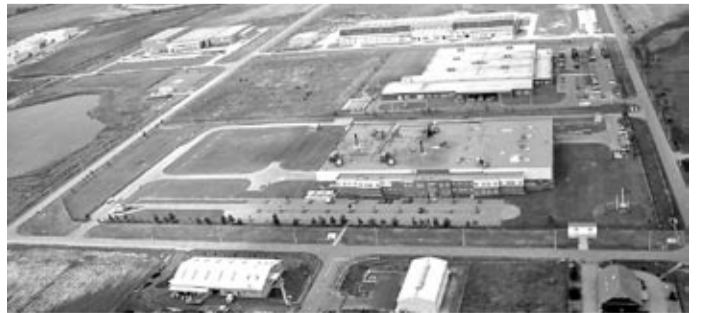
Az elnyert uniós támogatással, és a saját forrásokkal az ipari park teljes egészében közművesítetté vált.
